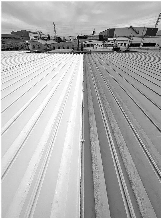
屋根左側が塗装済み
